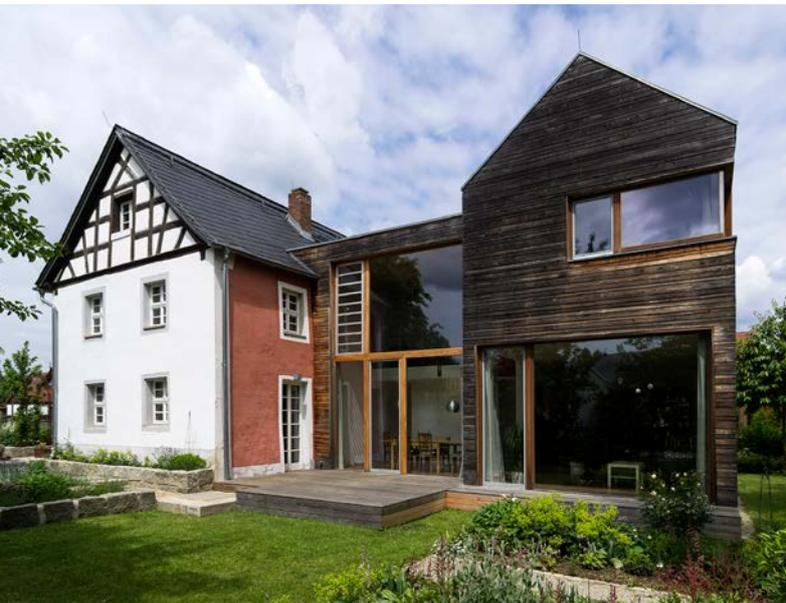
fortführt. Der Holzständerbau nimmt die Giebelständigkeit und das Satteldach des Altbaus auf und verbindet so zusammen mit dem gläsernen Zwischenbau ganz selbstverständlich Alt und Neu in der äußeren Erscheinung. Die energetische Sanierung sowie die behutsame Gestaltung der Außenanlagen runden die herausragende Baumaßnahme zudem vorbildlich ab.
